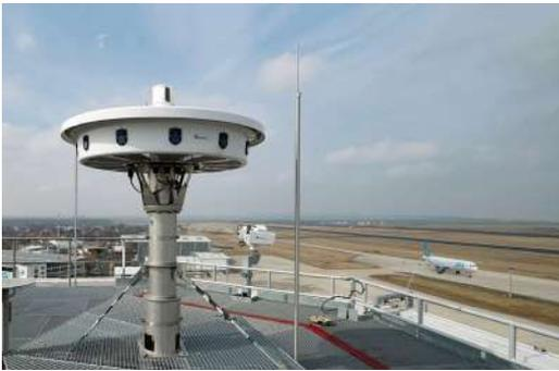
Auch sobald es draußen dunkel ist (oder nachts) ändert sich an der Sicherheit nichts. Wie im Tower kann man auch im RTC ein Befehrspult steuern, um das Licht am Flughafen (also Piste, Rollbahnen, Vorfeld) einzuschalten. Zudem sind die Kamerasysteme mit Infrarotsensoren ausgestattet, sodass ich das ganze Flughafengelände quasi durch Wärmebildkameras beobachten kann. So sehe ich auch bei kompletter Dunkelheit jedes Flugzeug, jedes Fahrzeug, aber auch jeden Hasen, der über das Vorfeld hoppelt.
